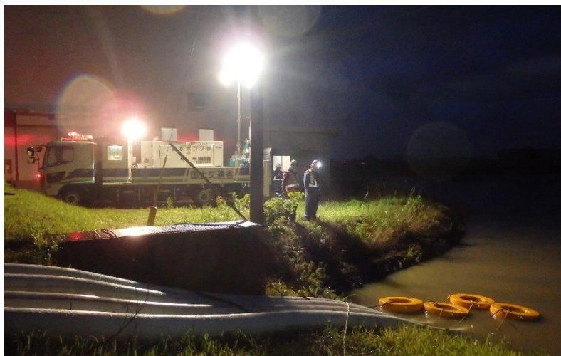
【久留米市(山ノ井排水機場):作業状況(応急対策班)】
