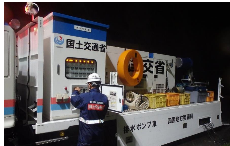
【久留米市(枝光排水機場):作業状況(応急対策班)】
