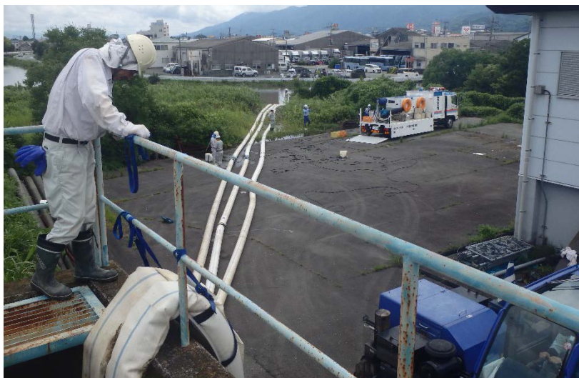
【久留米市(枝光排水機場):作業状況】
