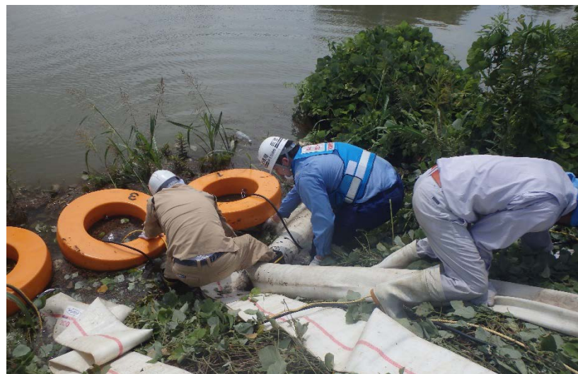
【久留米市(枝光排水機場):作業状況】
