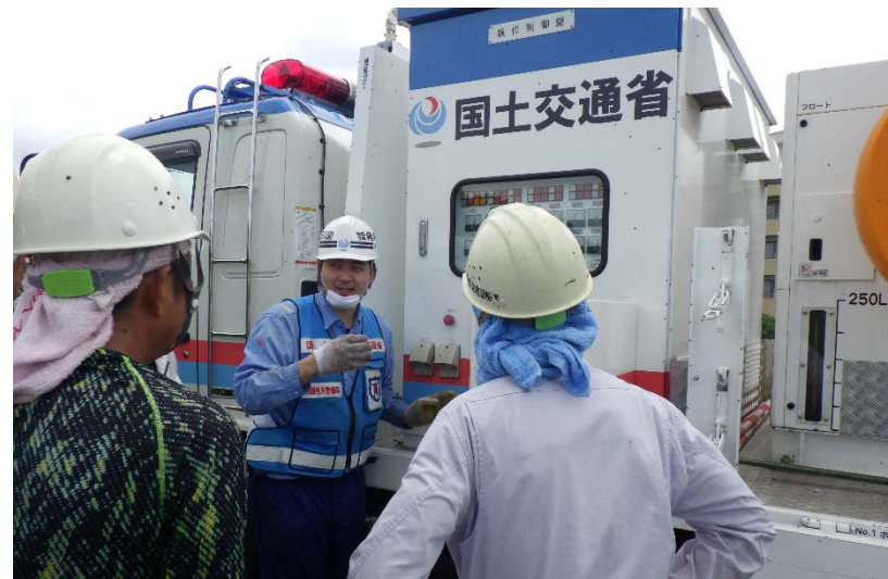
【久留米市(枝光排水機場):作業状況】
