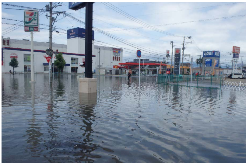
【久留米市:冠水状況】
