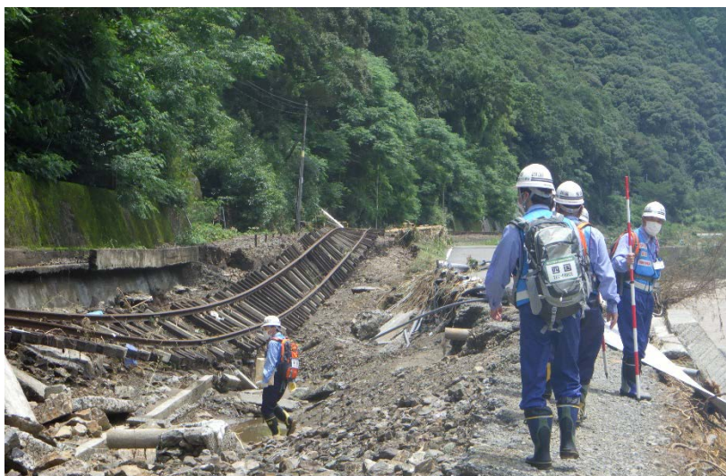
【八代市:被災状況調査】
