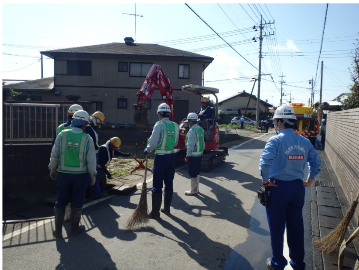
【栃木県佐野市:側溝清掃】
