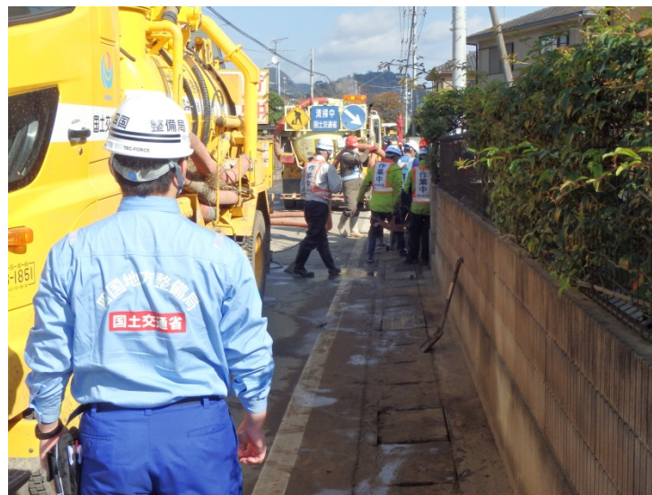
【栃木県佐野市:側溝清掃】
