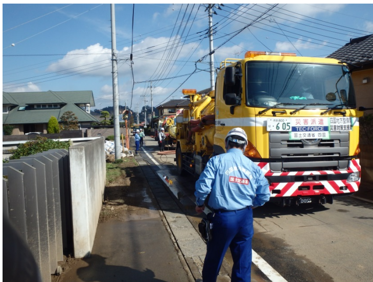
【栃木県佐野市:側溝清掃】
