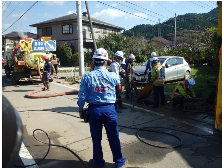
【栃木県佐野市:側溝清掃】
