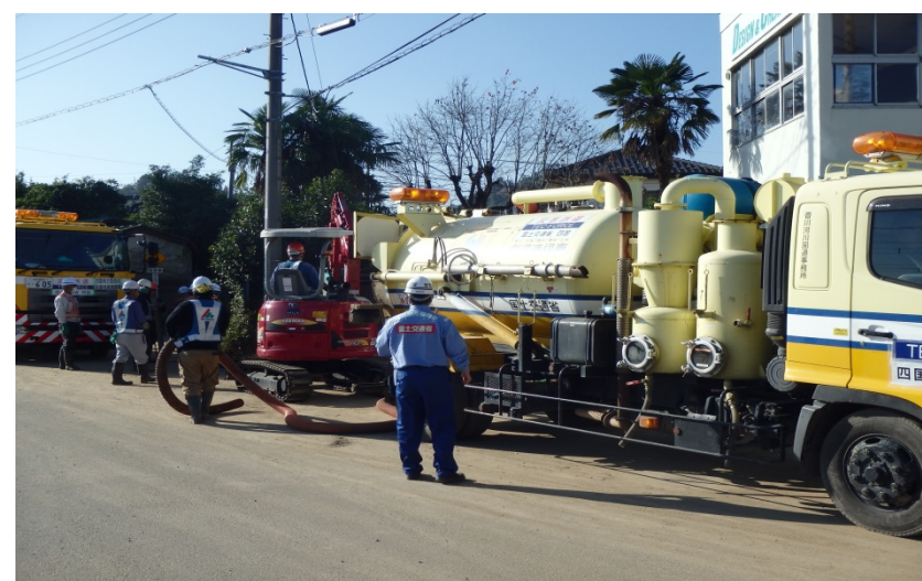
【栃木県佐野市：側溝清掃】
