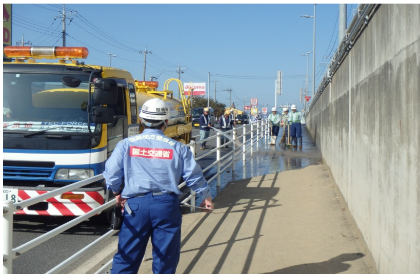
【栃木県佐野市：側溝清掃】
