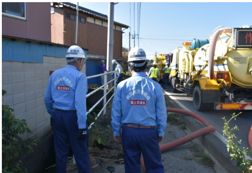
【栃木県栃木市：側溝清掃】
