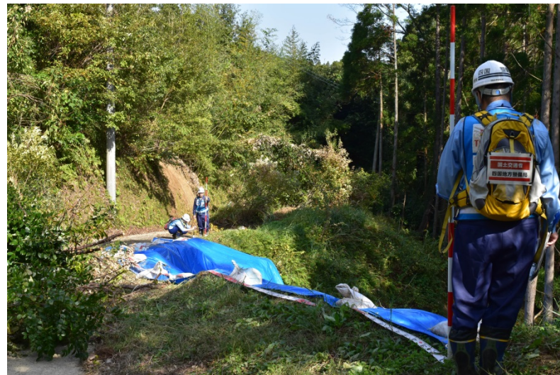
【千葉県茂原市:被災状況調査】
