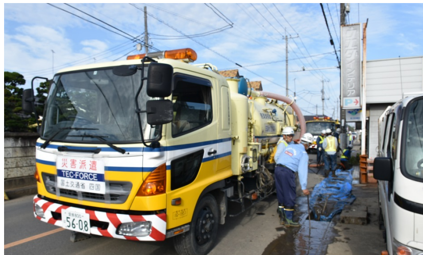
【栃木県栃木市:側溝清掃】
