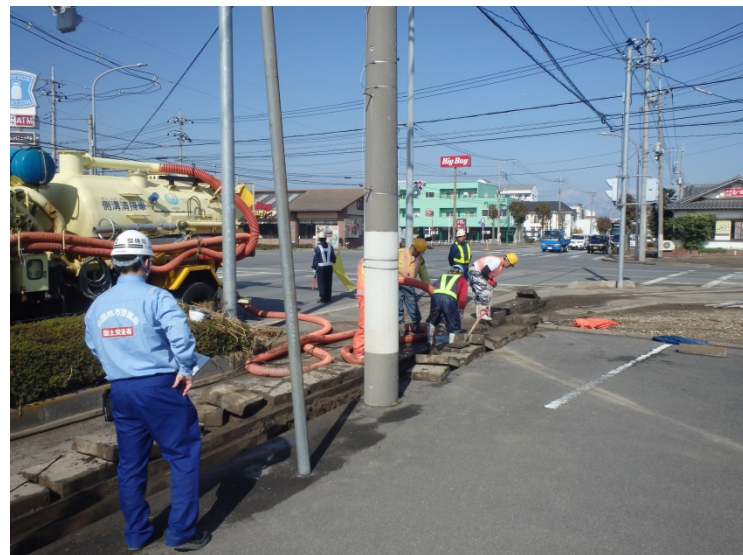
【栃木県佐野市:側溝清掃】
