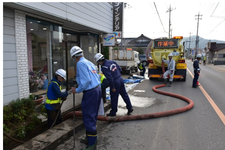
【栃木県栃木市:側溝清掃】
