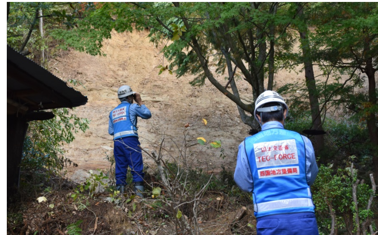
【福島県いわき市:被災状況調査】
