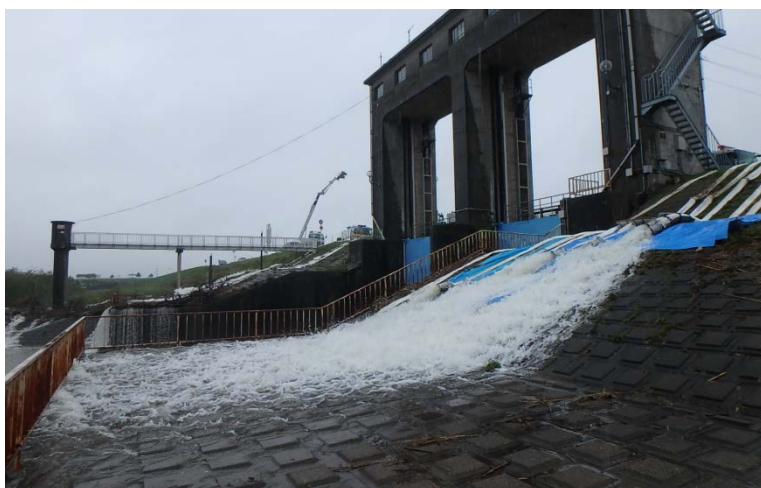
【印旛水門:排水作業】
