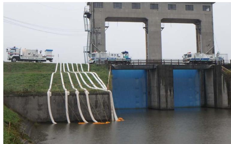
【印旛水門:排水作業】
