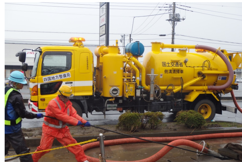
【栃木県佐野市:側溝清掃】
