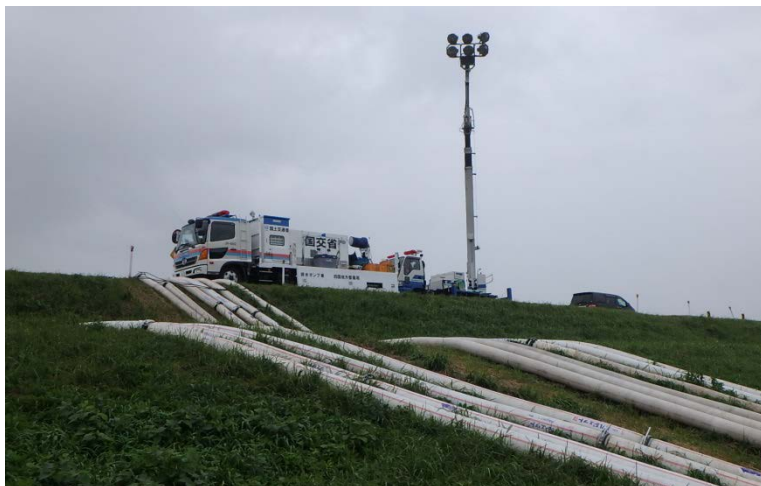
【印旛水門:排水作業】
