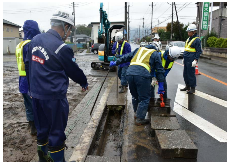
【栃木県栃木市:側溝清掃】
