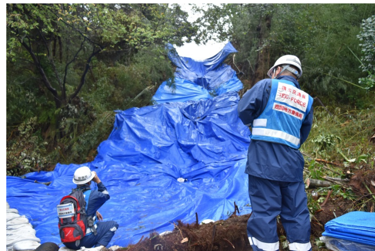
【千葉県佐倉市: 被災状況調査】
