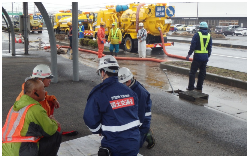
【栃木県佐野市:側溝清掃】
