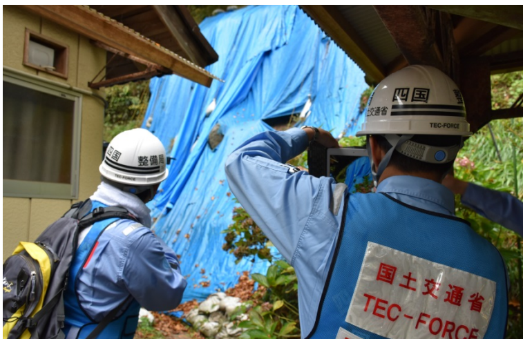
【福島県いわき市:被災状況調査】
