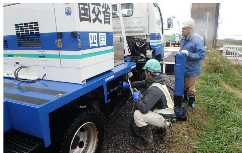
【印旛水門:車両確認】
