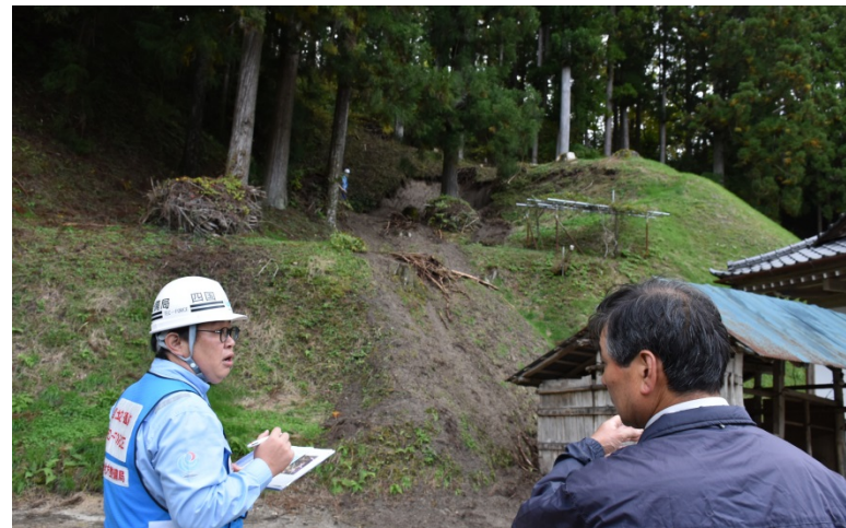
【福島県いわき市：被災状況調査】
