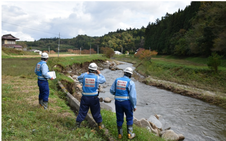
【福島県いわき市：被災状況調査】
