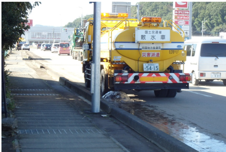
【栃木県栃木市:路面清掃】
