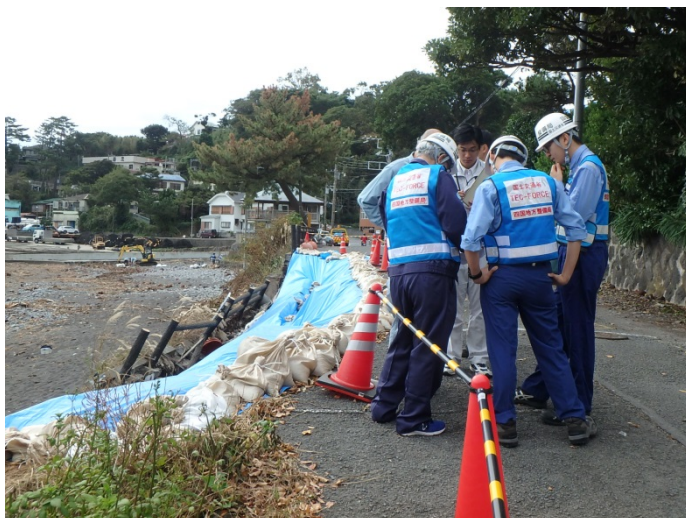
【神奈川県足柄下郡真鶴町:被災状況調査】
