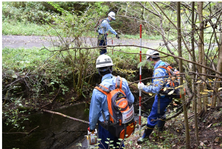
【長野県上田市:被災状況調査】
