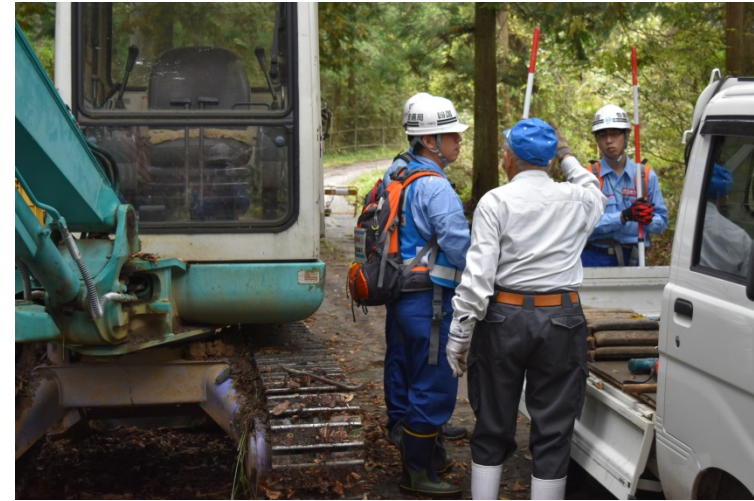
【長野県上田市:被災状況調査】
