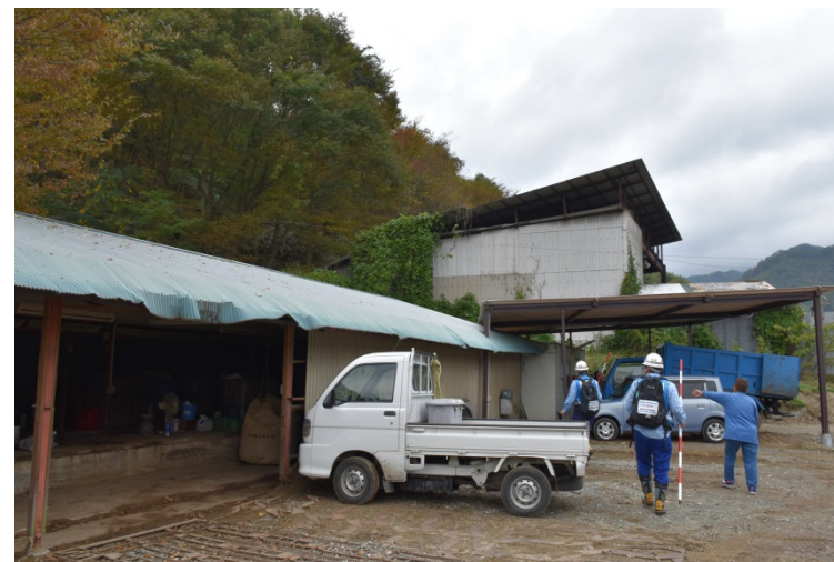
【長野県上田市：被災状況調査】
