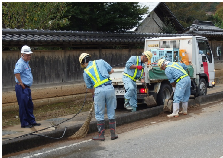
【栃木県鹿沼市:路面清掃】
