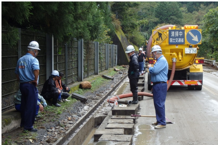
【栃木県鹿沼市:路面清掃】
