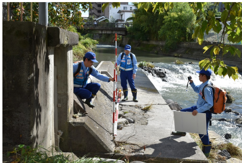
【長野県上田市: 被災状況調査】
