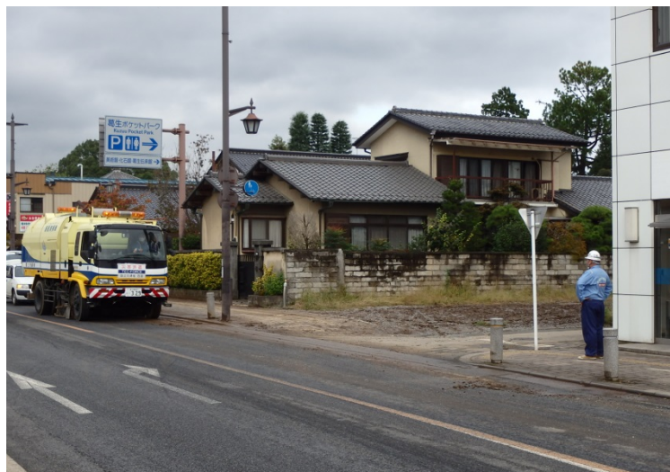
【栃木県鹿沼市:路面清掃状況】
