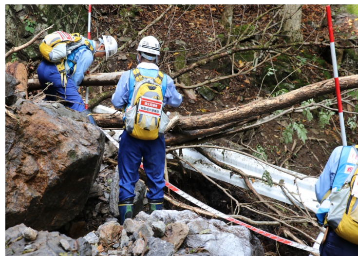
【群馬県多野郡上野村:被災状況調査状況】
