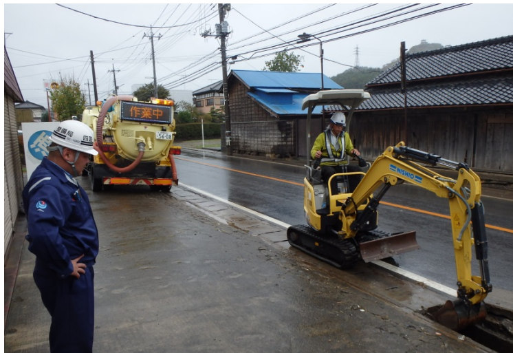
【栃木県佐野市:路面清掃状況】
