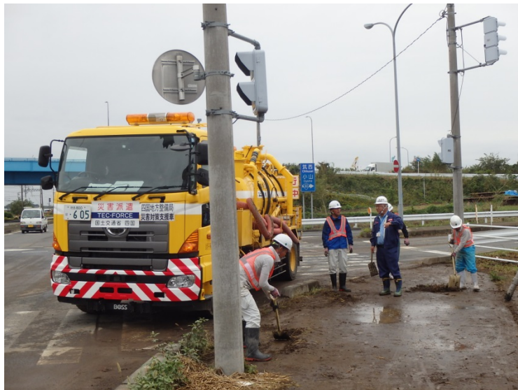
【栃木県佐野市:路面清掃状況】
