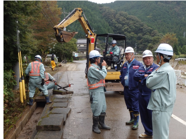
【栃木県鹿沼市:路面清掃状況】
