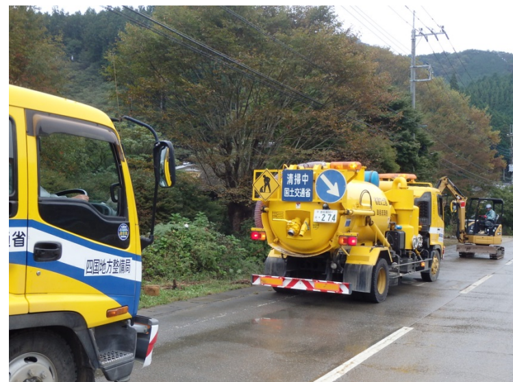
【栃木県鹿沼市:路面清掃状況】
