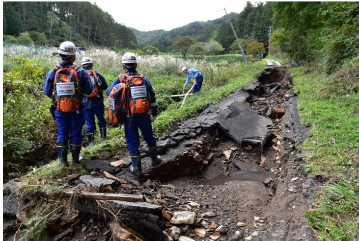
【長野県佐久市:被災状況調査状況】
