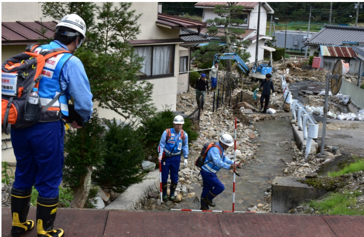
【長野県上田市:被災状況調査状況】
