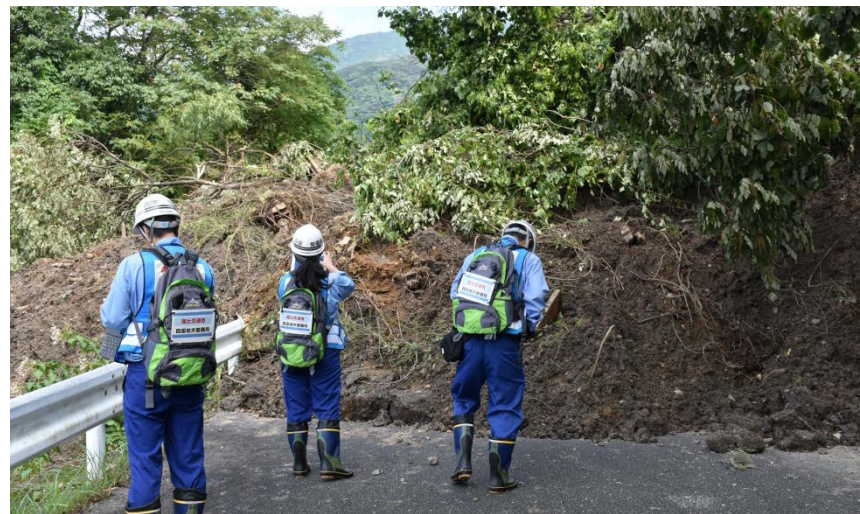
【砂防班：法面崩壊箇所調査状況(大町町)】
