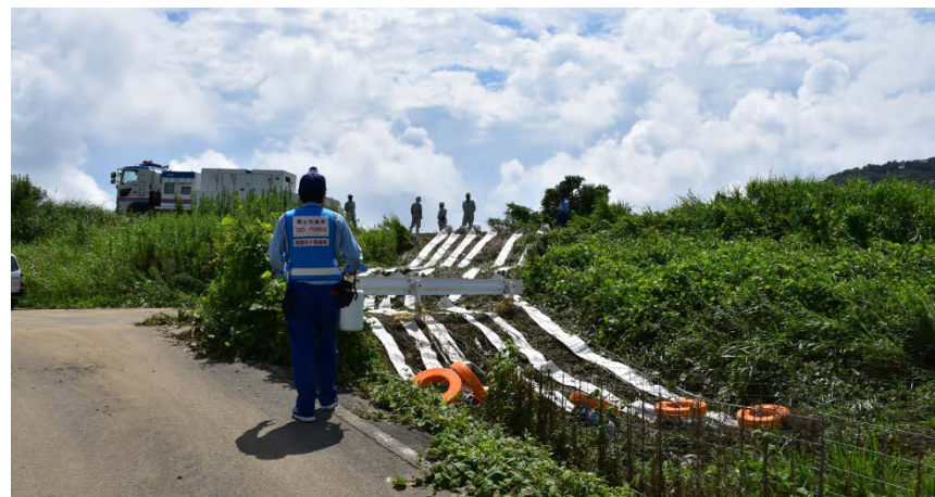
【応急対策班：設備点検(武雄市)】
