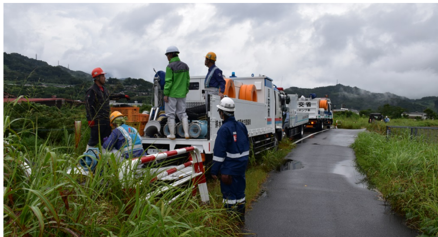
【排水ポンプ配置状況】
