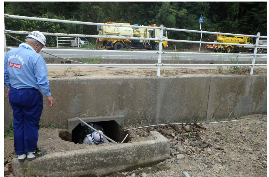
愛媛県宇和島市 国道378号 函渠清掃状況
