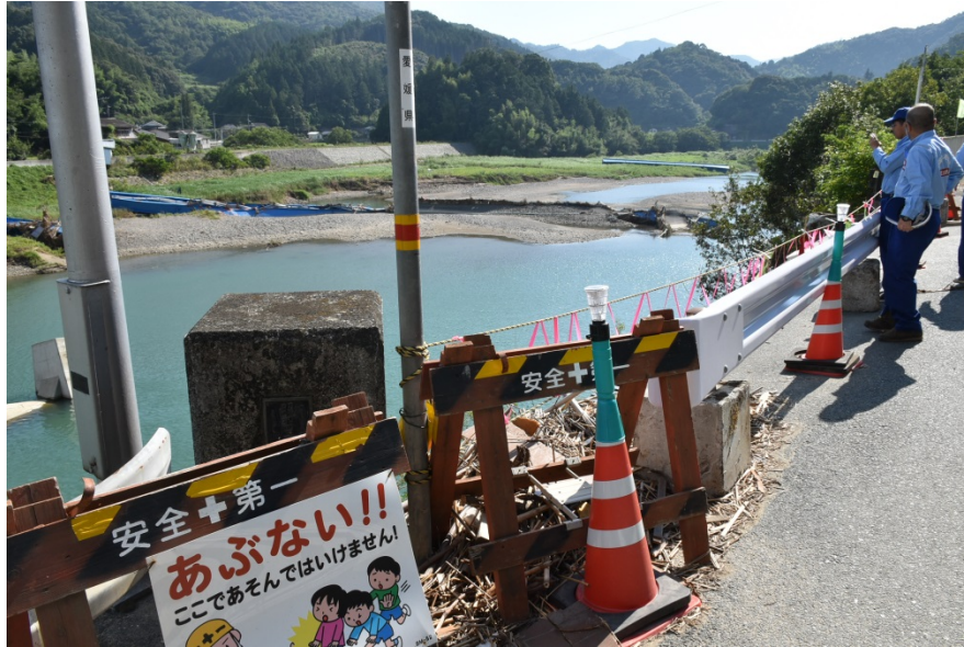
愛媛県大洲市 肱川中流部落橋
