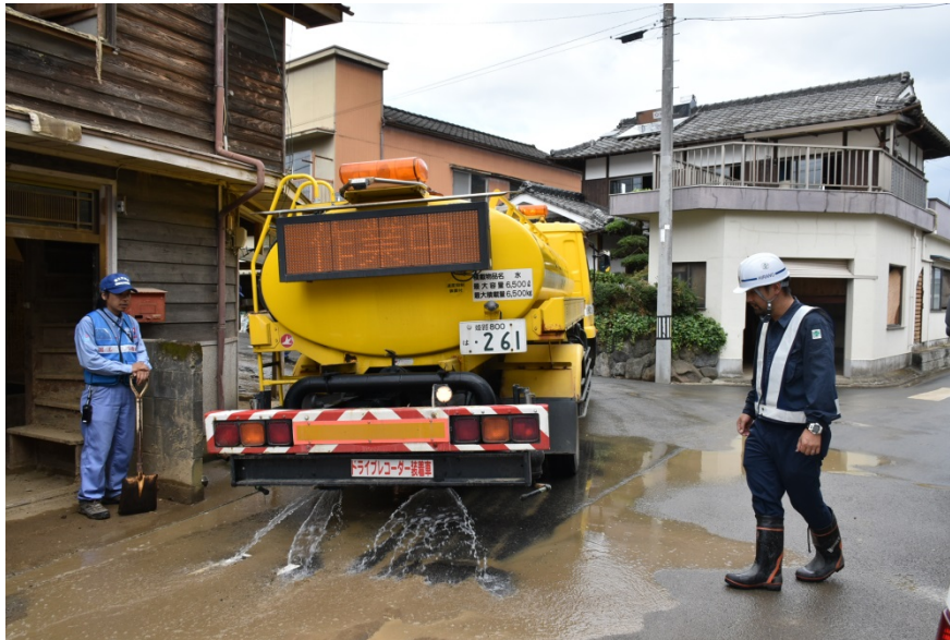
愛媛県西予市 野村町内 散水車稼働状況（関東地整）
