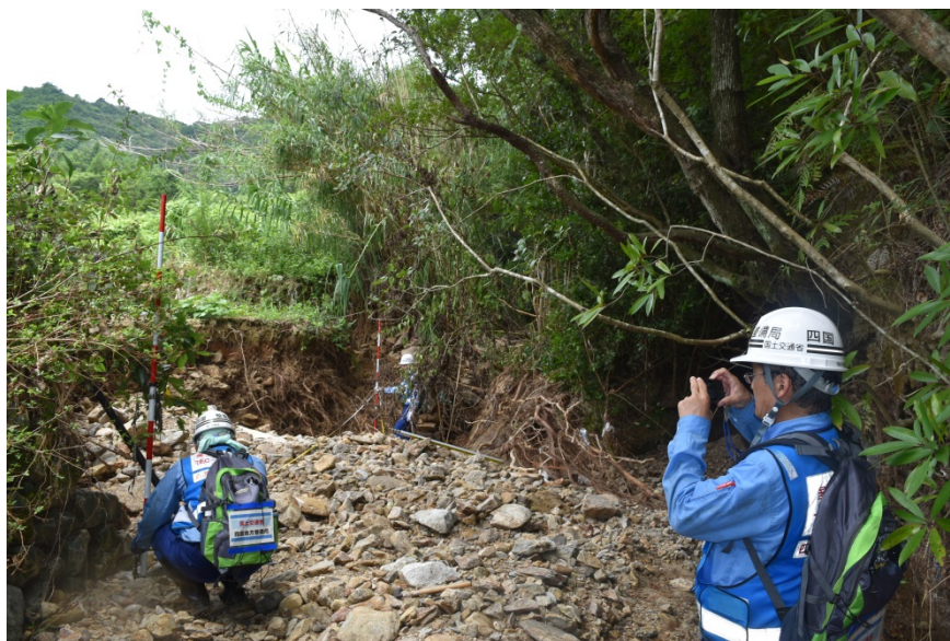
高知県大月町 平山地区 松谷川 現地調査状況
