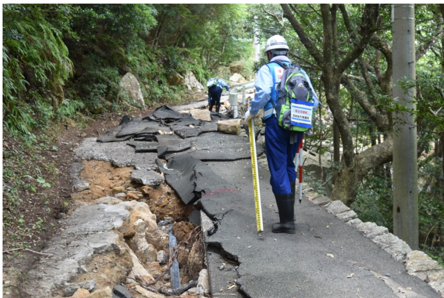
高知県大月町 平山地区 坪ノ後川 現地調査状況
