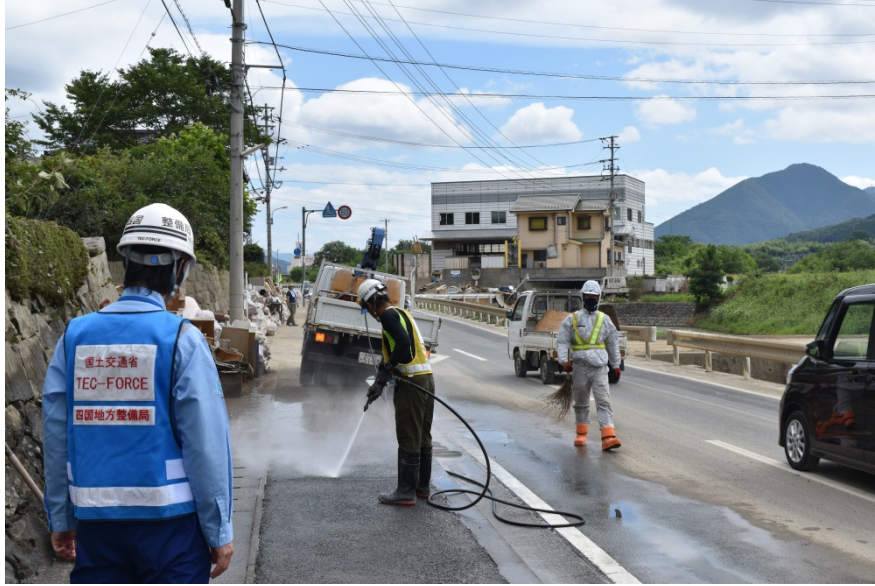
愛媛県大洲市 西大洲・菅田 道路清掃状況
