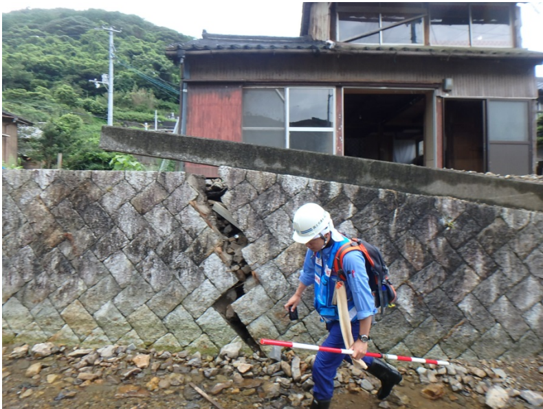
高知県大月町 橋浦地区 橋浦川 現地調査実施状況
