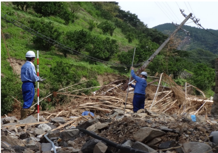
現地調査状況
