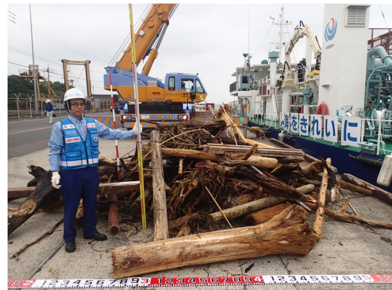
陸揚げした流木等の計測状況
