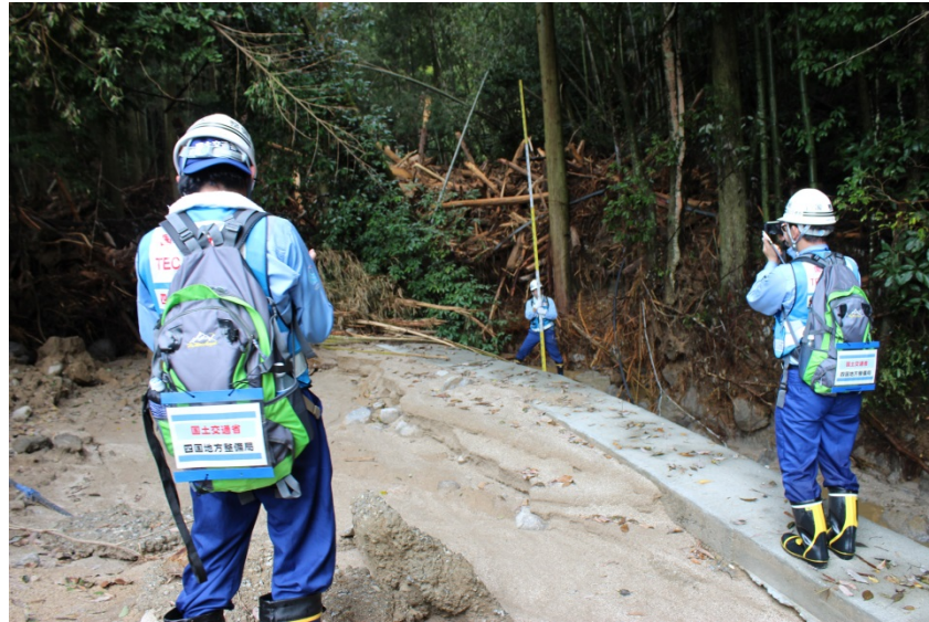
流木による川の閉塞状況
