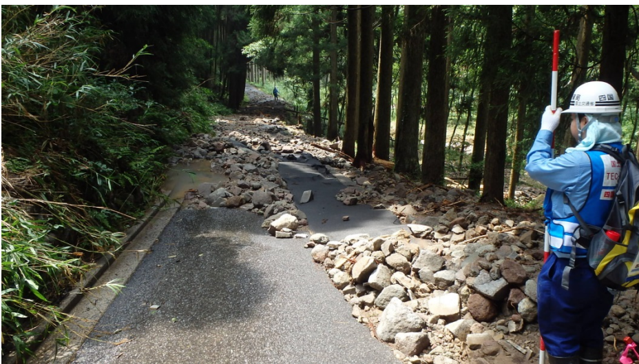
道路閉塞状況②
