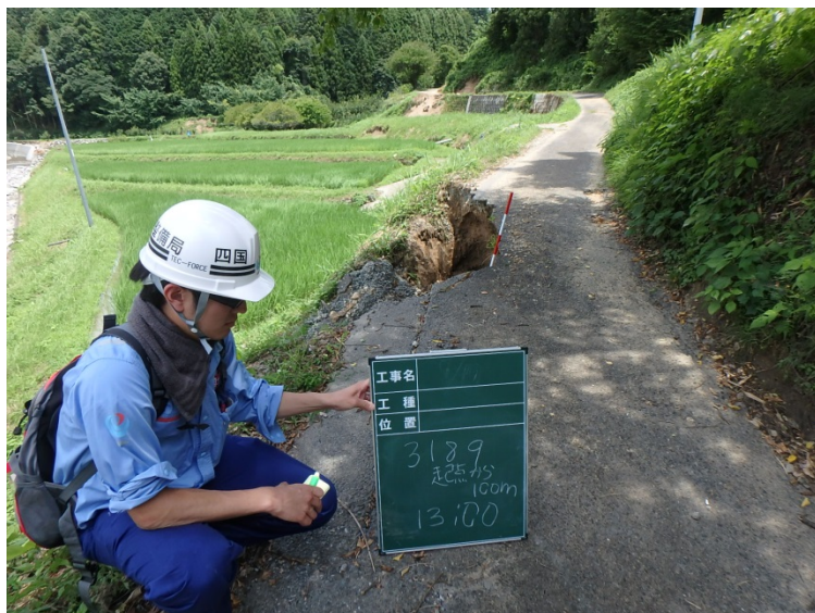
道路の陥没状況調査
