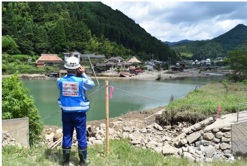
河川の被害状況調査①
