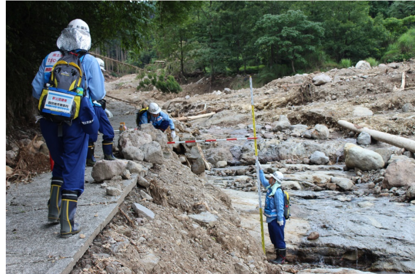
河川の被害状況調査①
