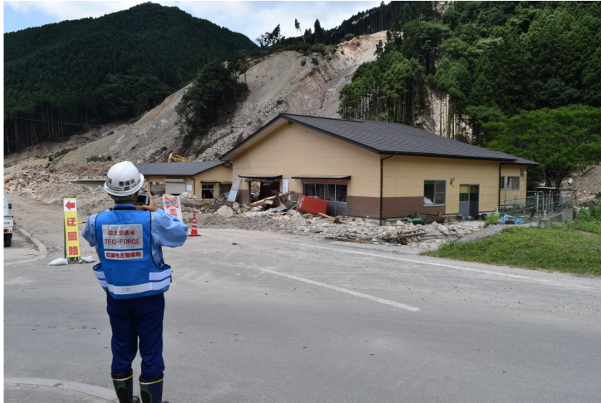
土砂災害による被害状況調査①
