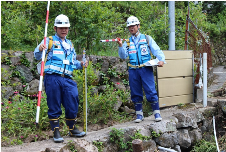
被災状況調査
