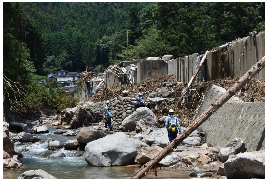
被災状況の現地調査(河川班)
