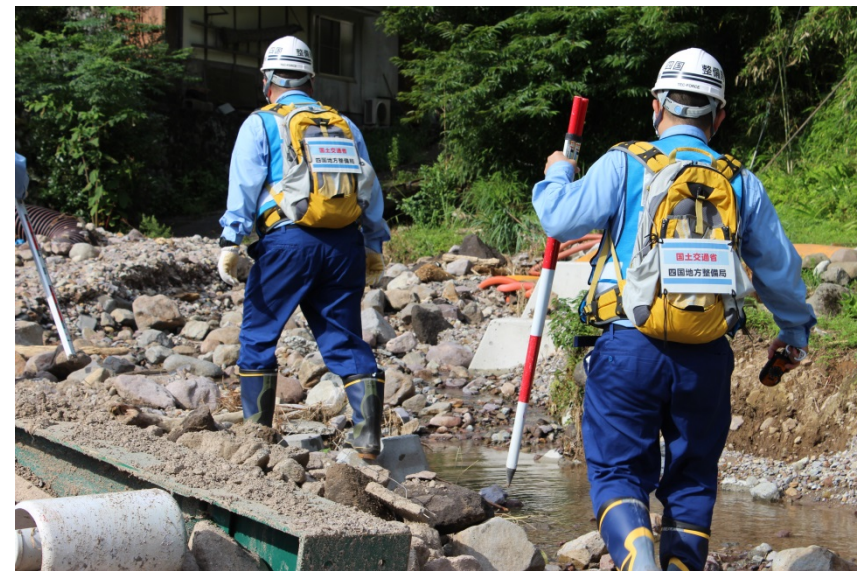
被災状況の現地踏査
