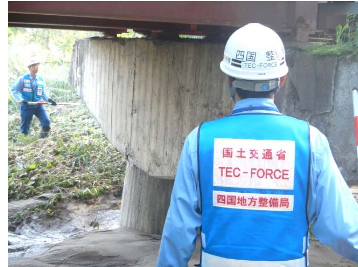
橋梁点検をする隊員(新栄橋)
