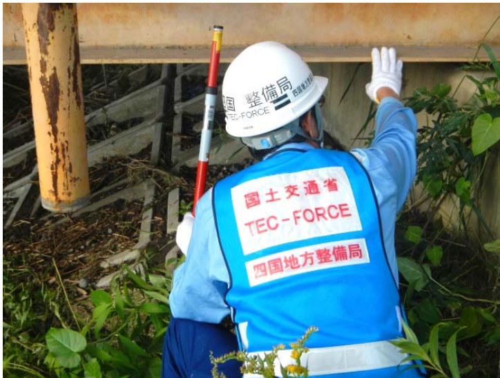
橋梁下部工の点検をする隊員(昭和橋)
