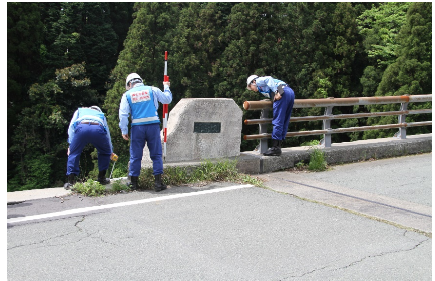
南阿蘇村の橋梁点検
