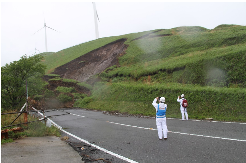
県道28号の崩落箇所での現地確認
