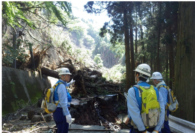
大規模な法面崩壊により通行不能となった村道を調査する道路班、砂防班の隊員(南阿蘇村垂玉地区)
