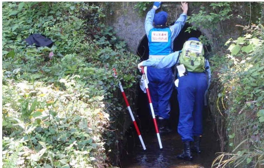
被災状況を確認
