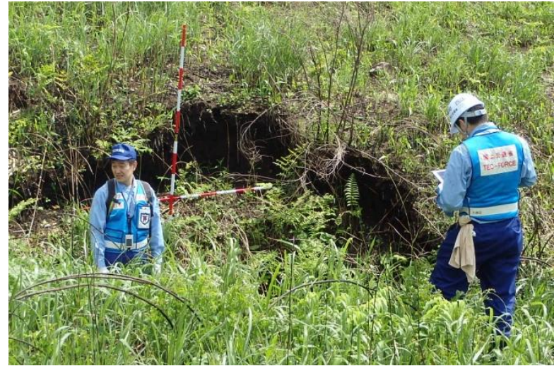
崩落箇所の現地調査を実施
