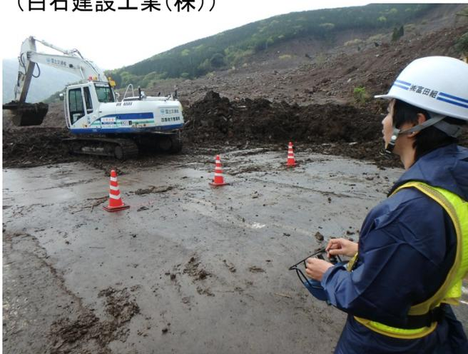
オペレーターによる遠隔操作の作業状況
