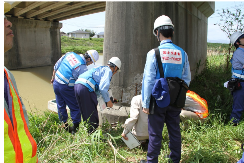
橋梁点検（六田橋）
