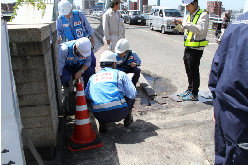
橋梁点検（泰平橋）
