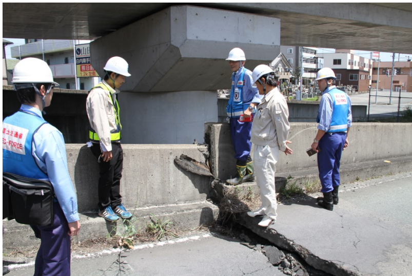
橋梁点検（平田高架橋）
