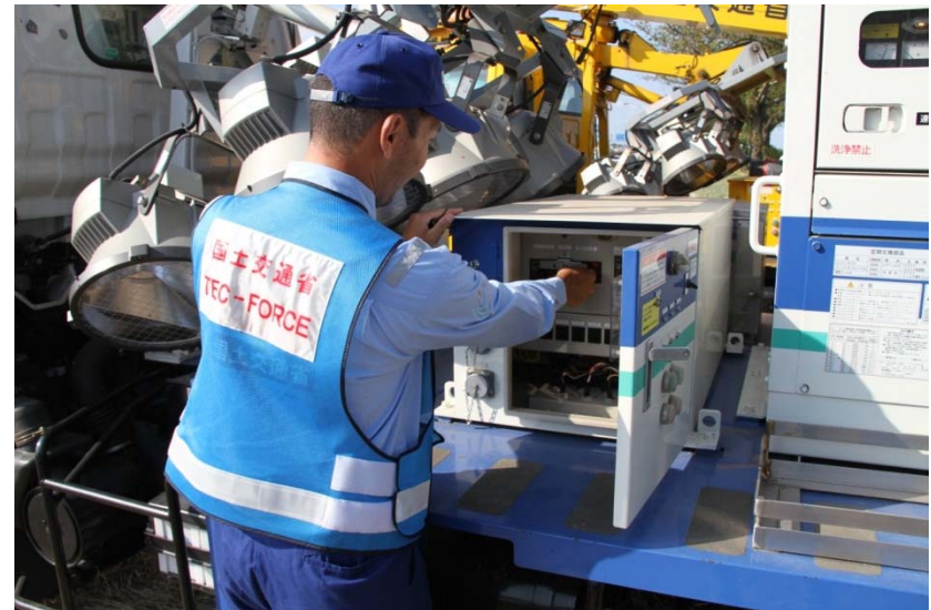
排水ポンプ車及び照明車の装備を確認する TEC-FORCE隊員
