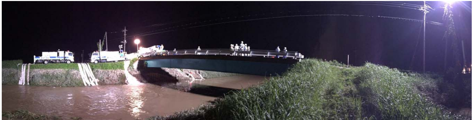
上大橋付近に照明車を設置し、24時間体制で排水活動を継続
