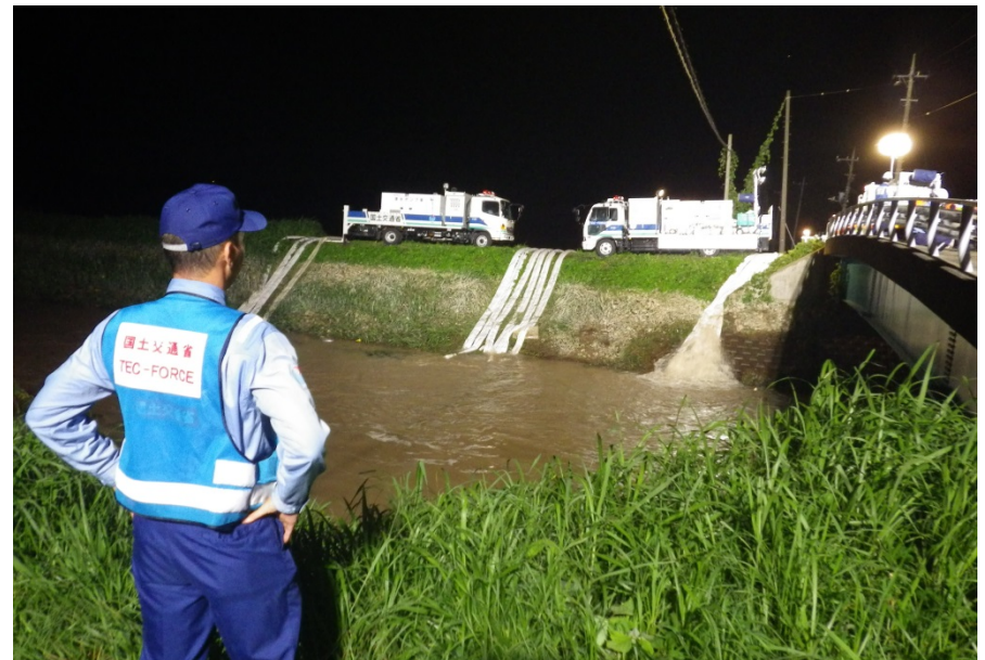
排水稼働状況を確認するTEC-FORCE隊員
