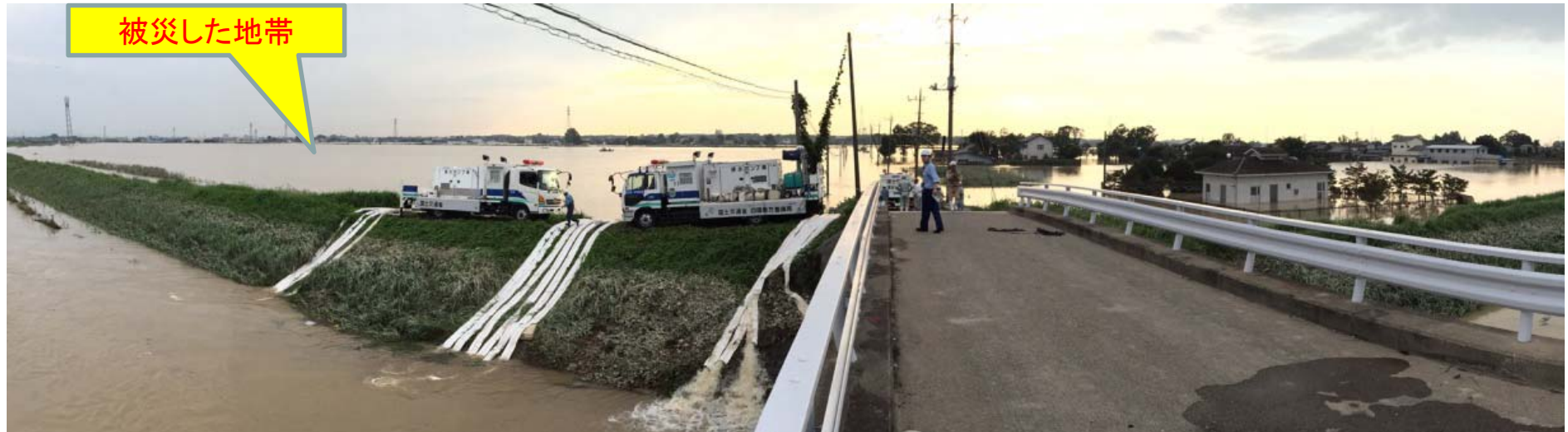
上大橋付近に排水ポンプ車を設置し、排水作業を開始
