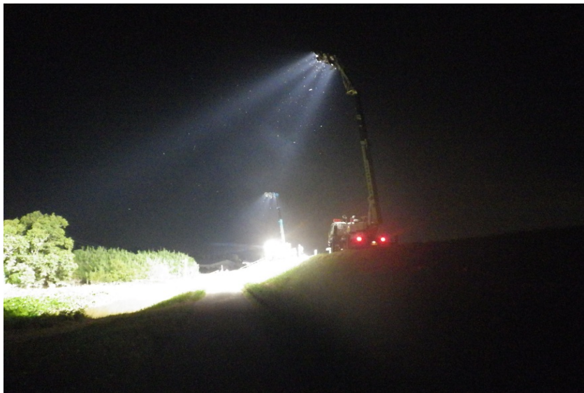
照明車を使用した24時間体制での排水作業
