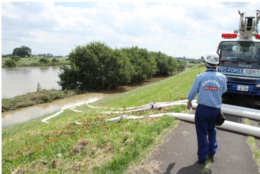
排水開始と排水状況の確認
