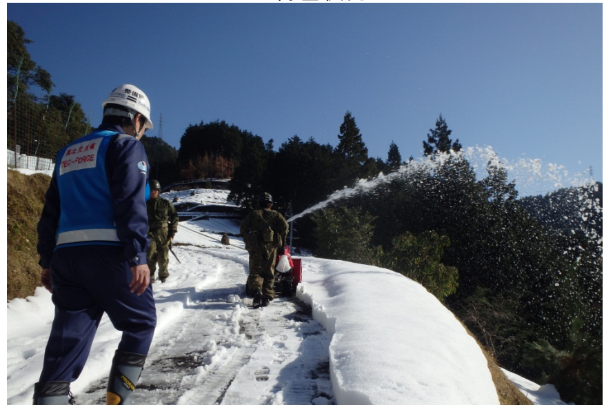
除雪後の状況
