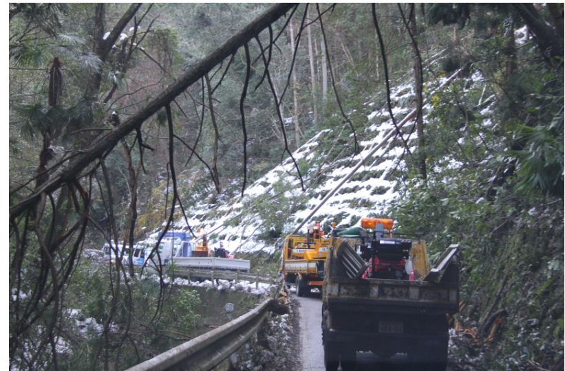
現地への運搬状況
