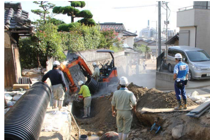
仮設排水管設置監督状況②
