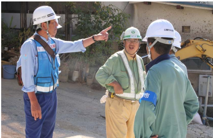
広島市水道局と現場協議
