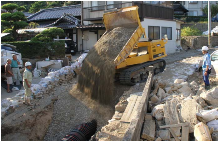
仮設排水管設置監督状況①
