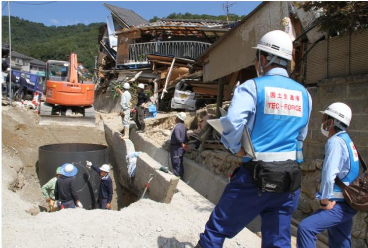
鋼製ケーシングチューブ埋設監督状況
