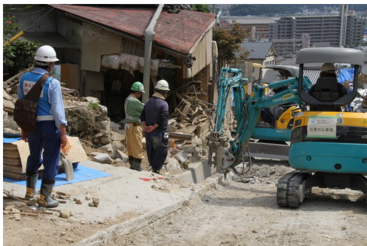
がれき撤去監督状況
