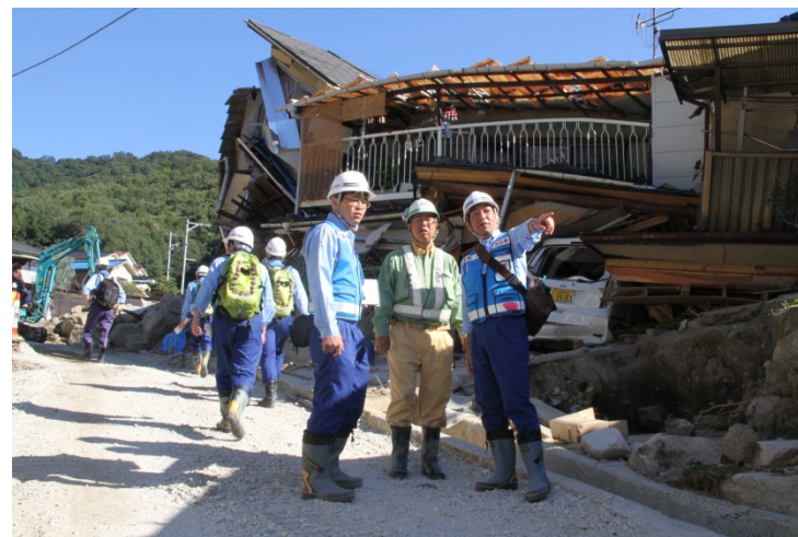
工事業者との現地調整
