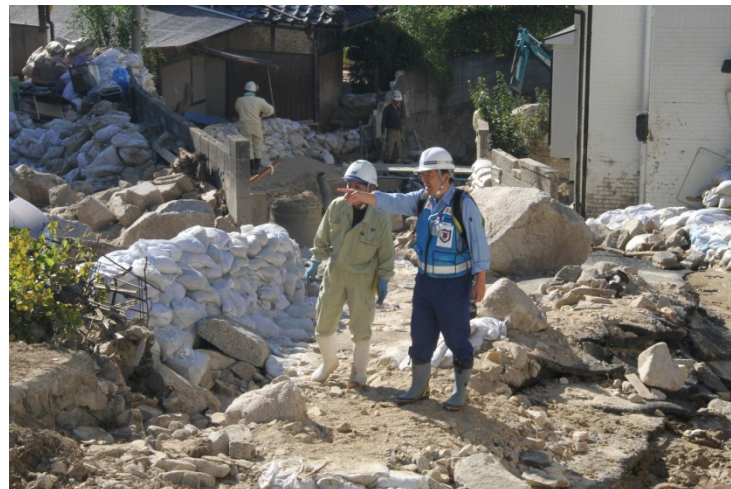
工事業者との現地調整
