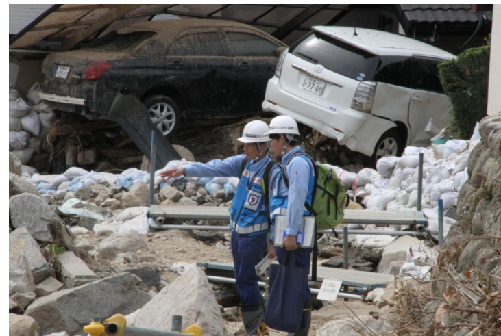
水路等の被災状況調査
