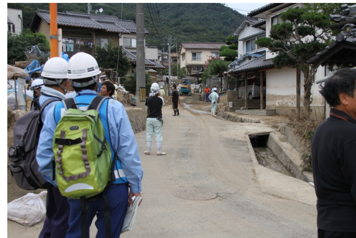
土砂撤去監督状況 3日間で重機の所まで撤去完了
