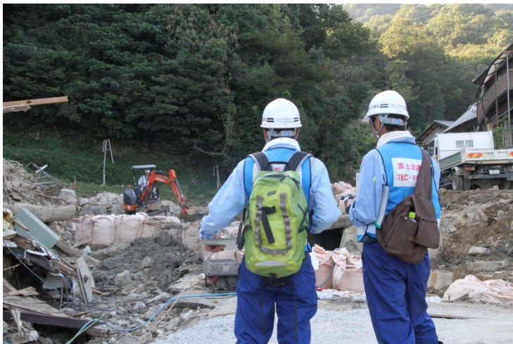
土砂撤去の監督状況
