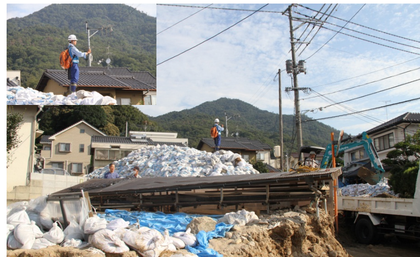
土囊の上から写真撮影(緑井地区)
