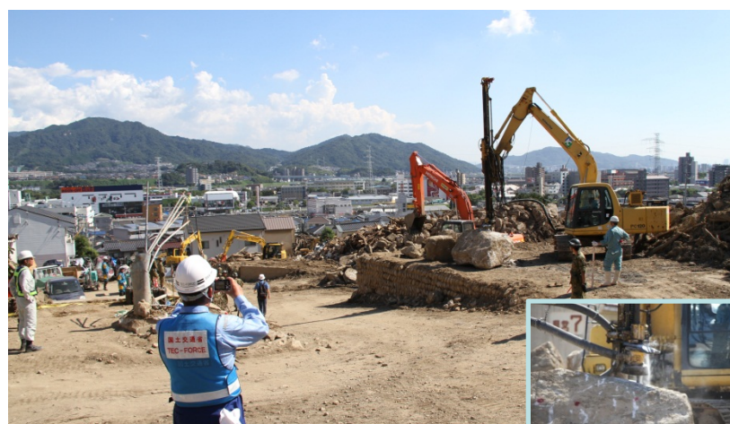
BHドリルによる破碎状況の写真撮影
