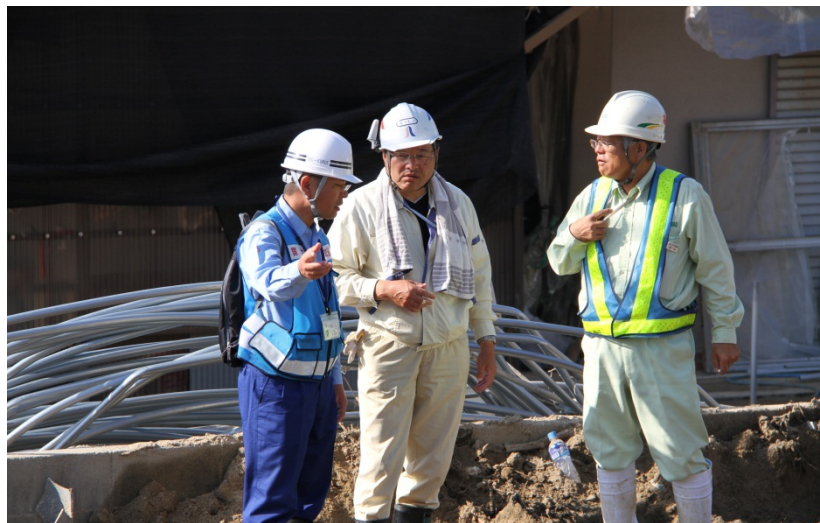
工事業者との現地調整(緑井地区)
