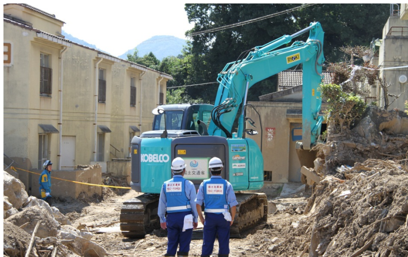
土砂撤去の監督状況(八木地区)
