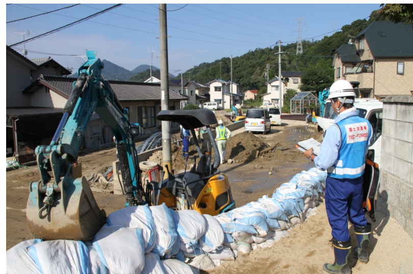
土砂撤去の監督状況(緑井地区)
