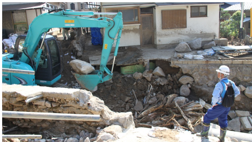
土砂撤去の監督状況(緑井地区)
