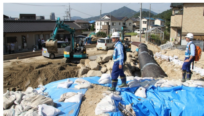
土砂撤去の監督状況(緑井地区)
