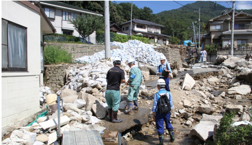
流水箇所の確認(緑井地区)
