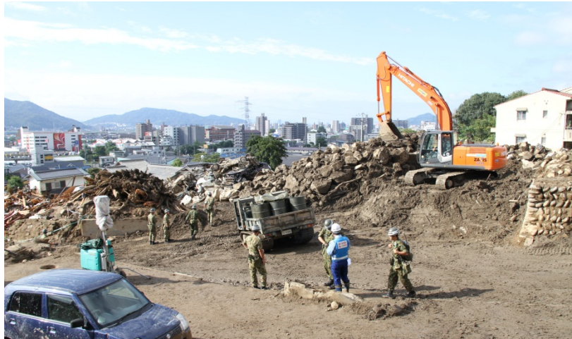
自衛隊との現場調整(八木地区)
