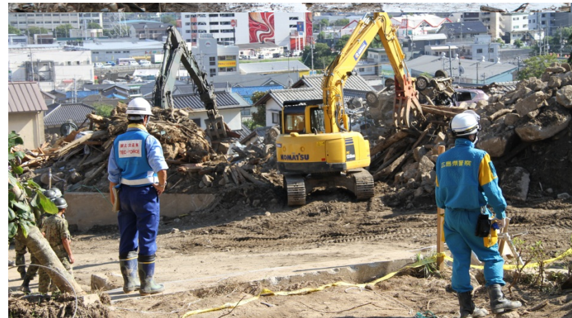
土砂撤去の監督状況
