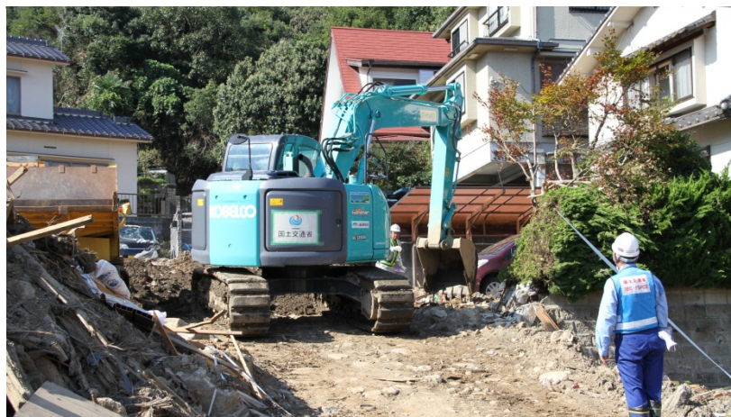
民家前面を土砂撤去
