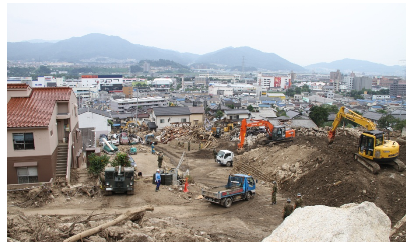
土砂撤去の周辺状況(八木地区)
