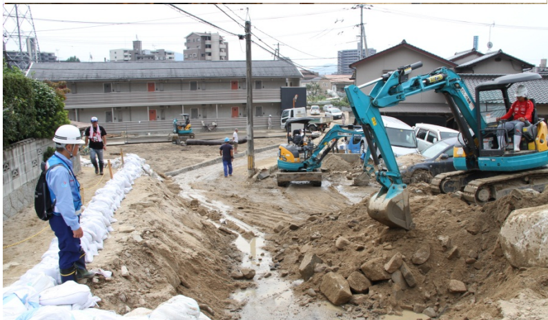
土砂撤去の監督状況(緑井地区)
