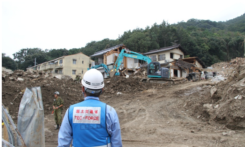
土砂撤去の監督状況(八木地区)
