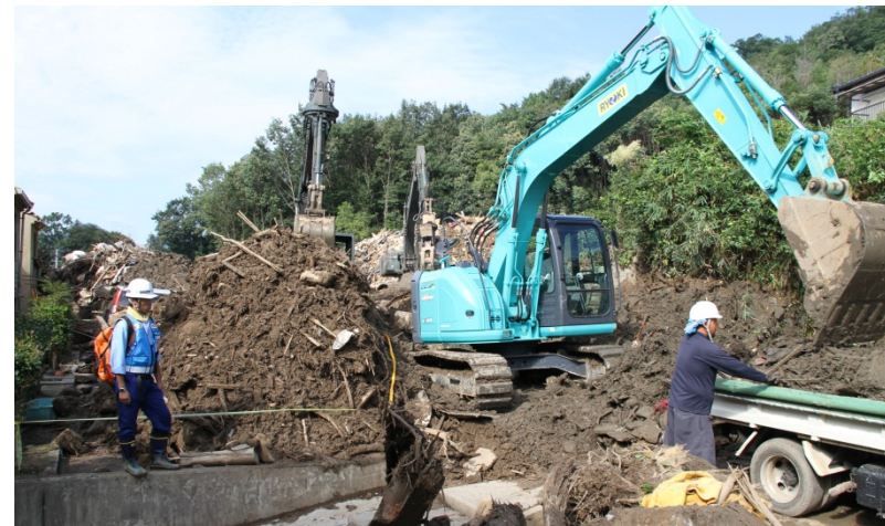
土砂撤去の監督状況(八木地区)
