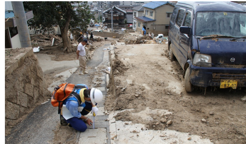
水路の状況調査(八木地区)
