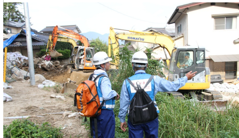
工事監督の打ち合わせ(緑井地区)
