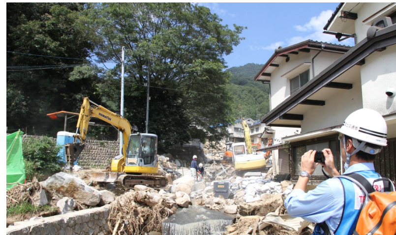
撤去状況の写真撮影(緑井地区)
