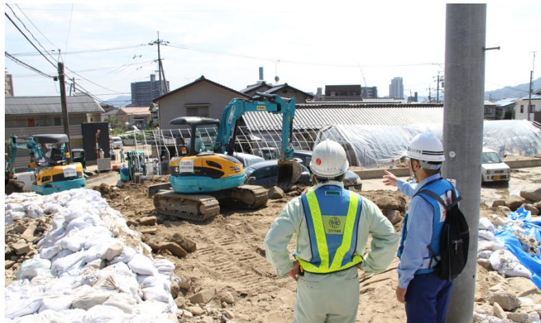
土砂撤去の工事業者との調整(緑井地区)
