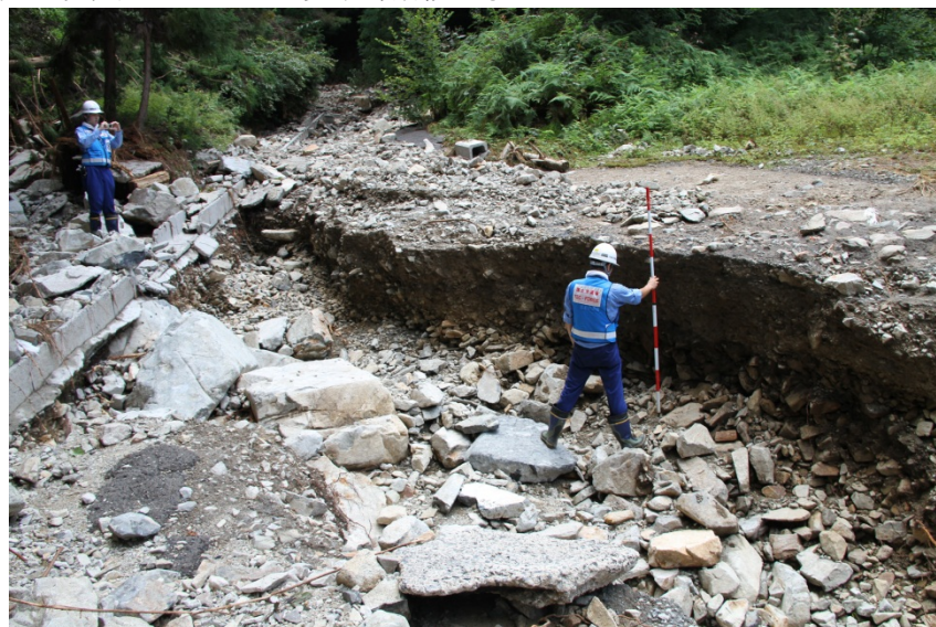
溪流点検調査
