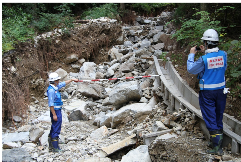
溪流点検調査
